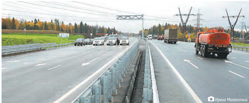
Дорога, по оценкам строителей, прослужит 100 лет
