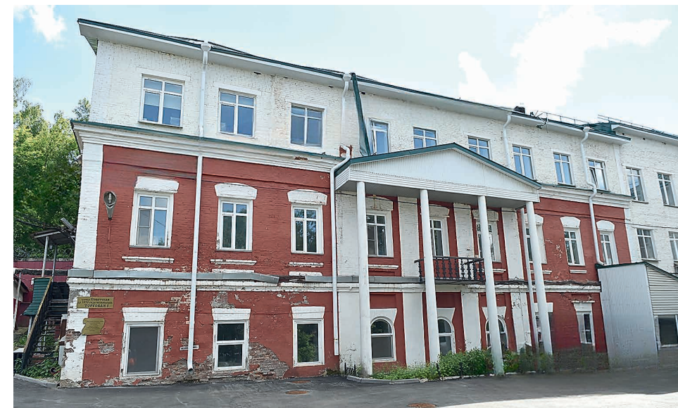
«ЗАВОД ШПАГИНА». ЗДАНИЕ ЗАВОДУПРАВЛЕНИЯ
