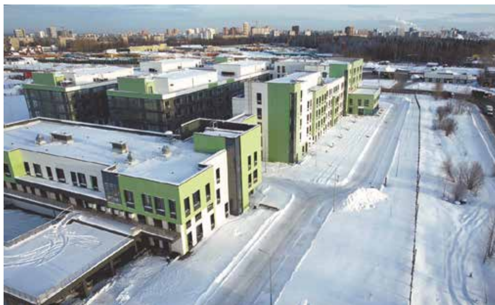
Комплекс зданий новой краевой инфекционной больницы
