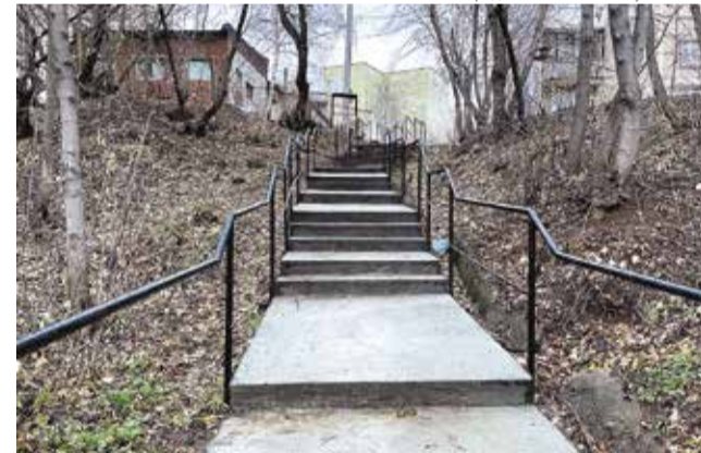
Лестница вблизи дома на ул. Чехова, 6 после ремонта
