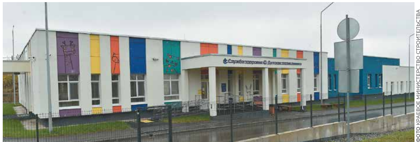
ФОТО КРАЕВОЕ МИНИСТЕРСТВО СТРОИТЕЛЬСТВА
