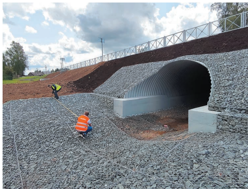
Мост через ручей на автомобильной дороге регионального значения Очёр — Верещагино — Сива
