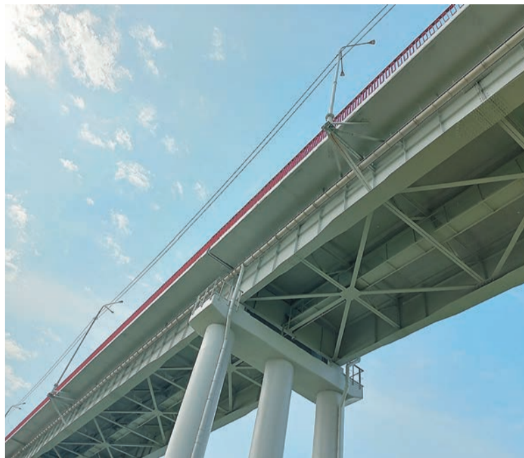
Мост через реку Вишеру в Чердынском городском округе
