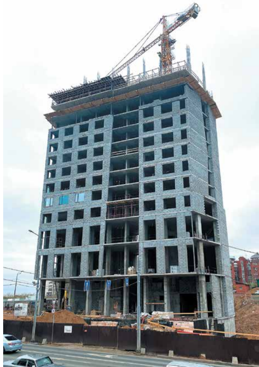
Строительство пятизвёздочной гостиницы в составе МФЦ «Эспланада» планируется завершить в этом году
