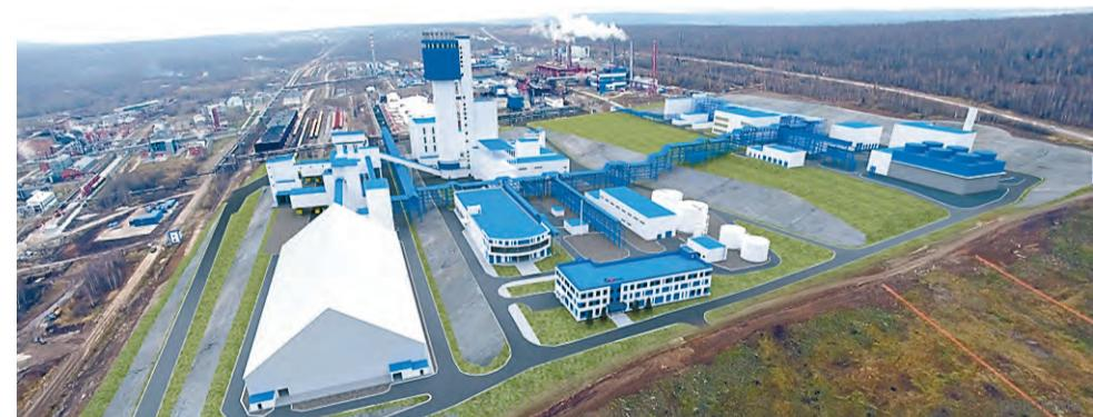
получения продукта протекает без образования некондиции, твёрдых и жидкых отходов. Выбросы от башни прилирования с очистным устройством значительно ниже, чем при производстве товарного карбамида другим способом — в установке грануляции.
