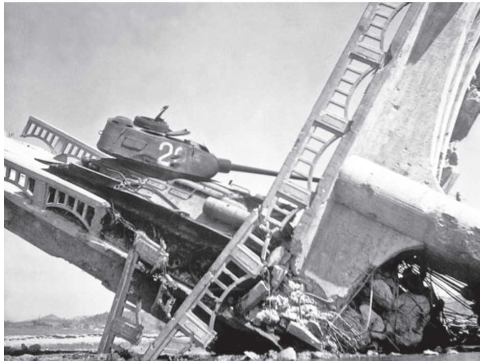
«Корейский» танк Т-34 на разрушенном американцами мосту
