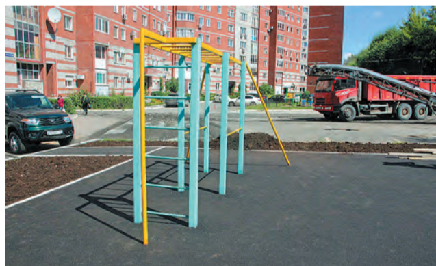
Во дворе дома на ул. Семченко, 6 вовсю идут работы по благоустройству
