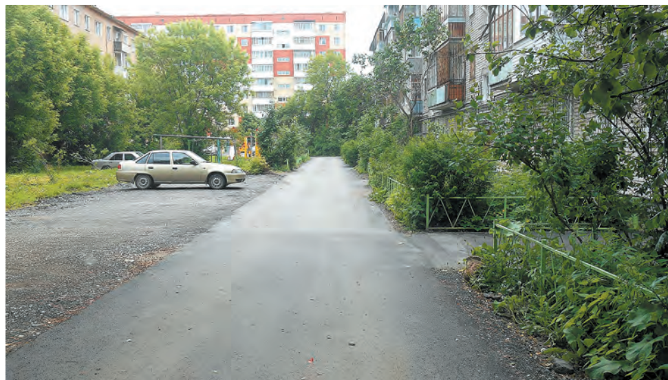
...и после проведения благоустроительных работ
