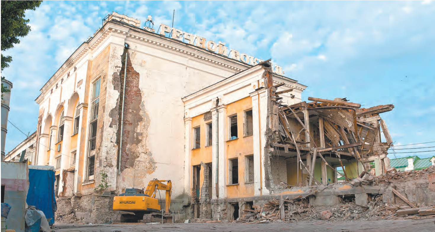
В процессе реконструкции Речного вокзала наиболее ветхое восточное крыло было полностью демонтировано
