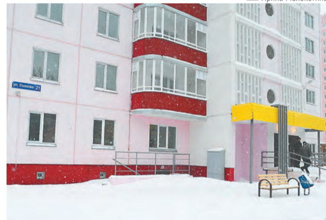
В 2016 году в Перми был сдан долгострой на ул. Ушакова, 21
