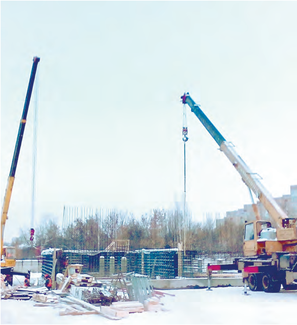
Объём финансирования инвестиционной программы ООО «Новогор-Прикамье» в сфере водоснабжения, водоотведения и очистки сточных вод на территории Перми на 2015–2017 годы составляет почти 3 млрд руб. В 2015 году в рамках программы вложено около 600 млн руб.
