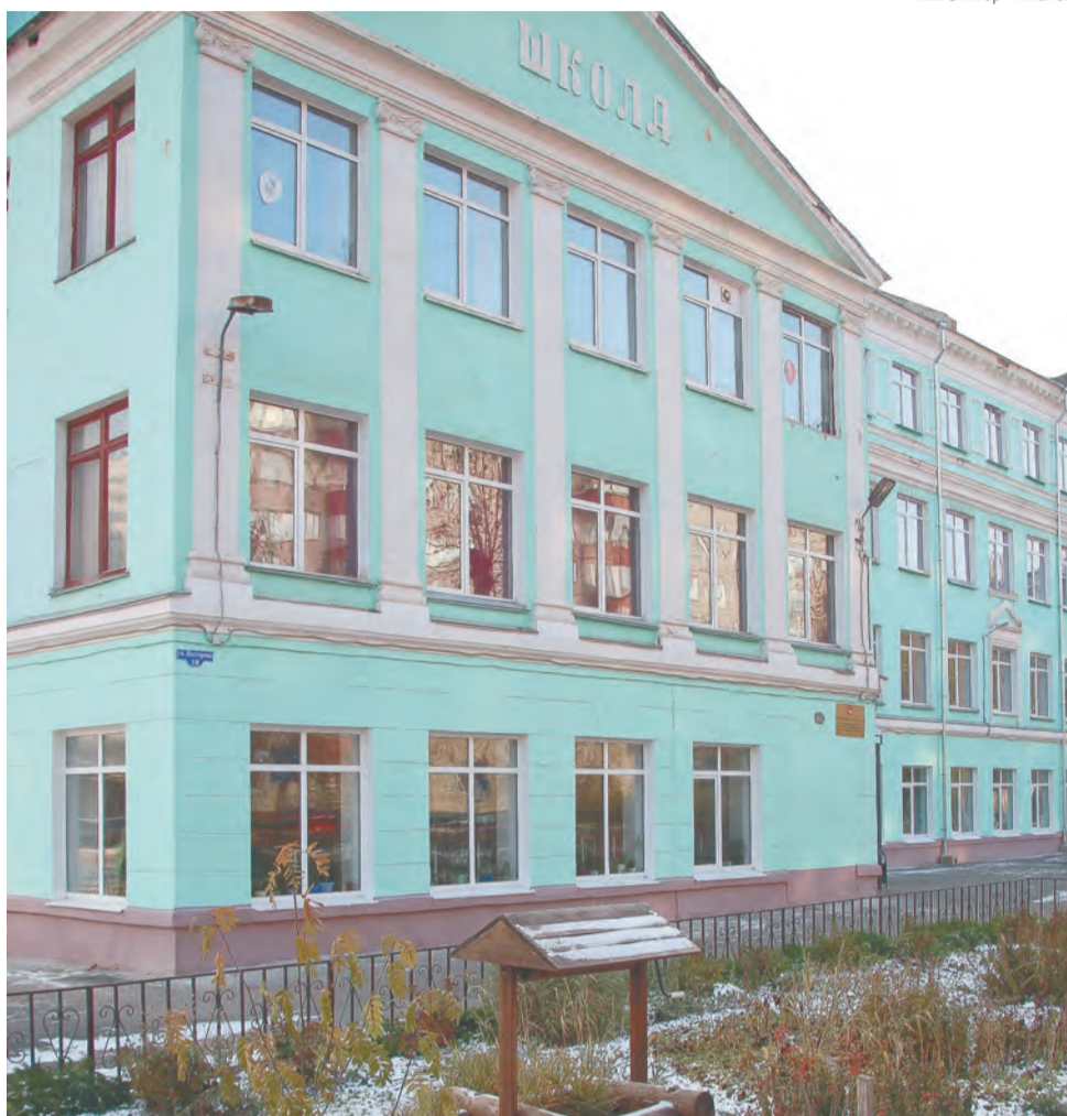
Существующему зданию школы №42 давно требуются дополнительные площади
