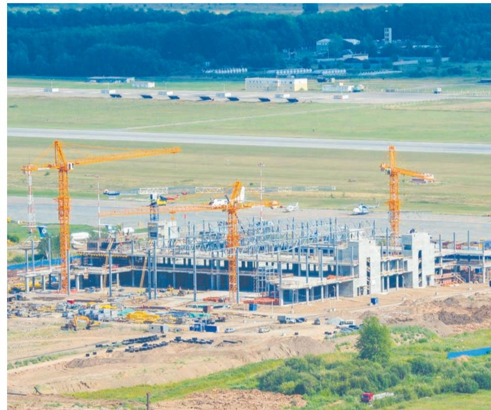
За 11 месяцев строительства нового аэровокзального комплекса выполнен значительный объём работ: уже готов свайный фундамент здания, произведена гидроизоляция, установлен арматурный каркас. Конструкции надземной части готовы на 50%. На прошлой неделе губернатор Виктор Басаргин проинспектировал строительство нового терминала. Глава региона выезжает на место стройки раз в квартал, чтобы лично проконтролировать все процессы.
