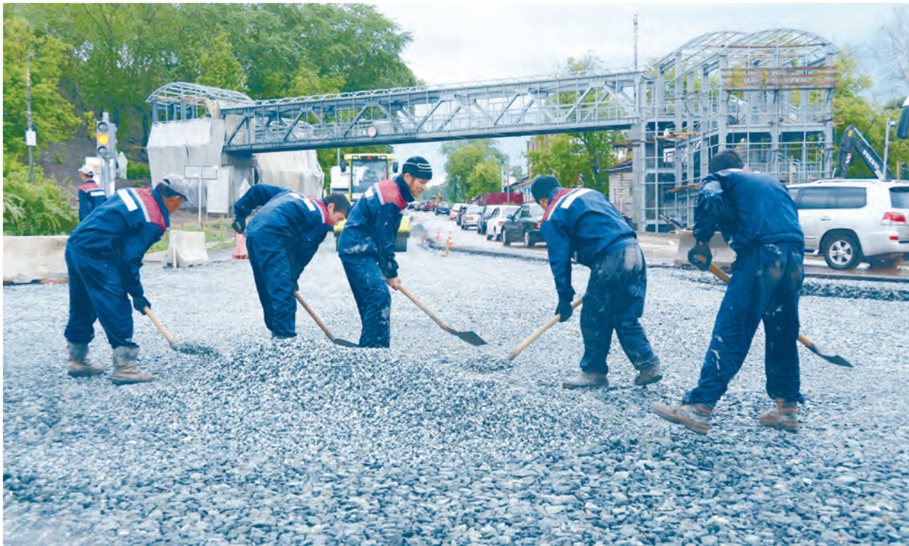
Работы на площади Восстания идут по плану, реконструкция завершится к октябрю нынешнего года
