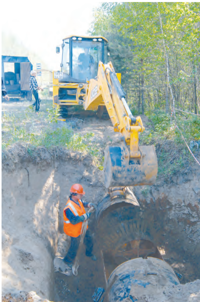
Перед санацией водовод чистят специальным металлическим ершом
