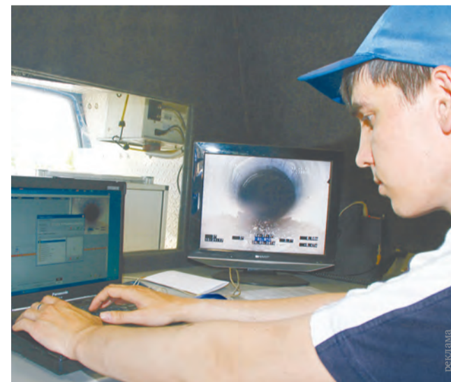
Идёт теледиагностика трубопровода после ремонта
