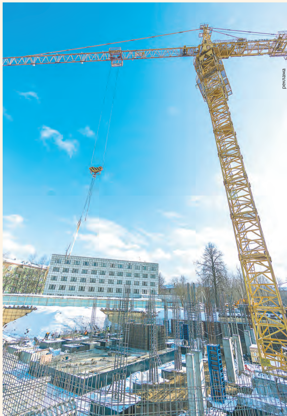
Строительство первой очереди ЖК «Гулливёр» в квартале №179 идёт полным ходом
