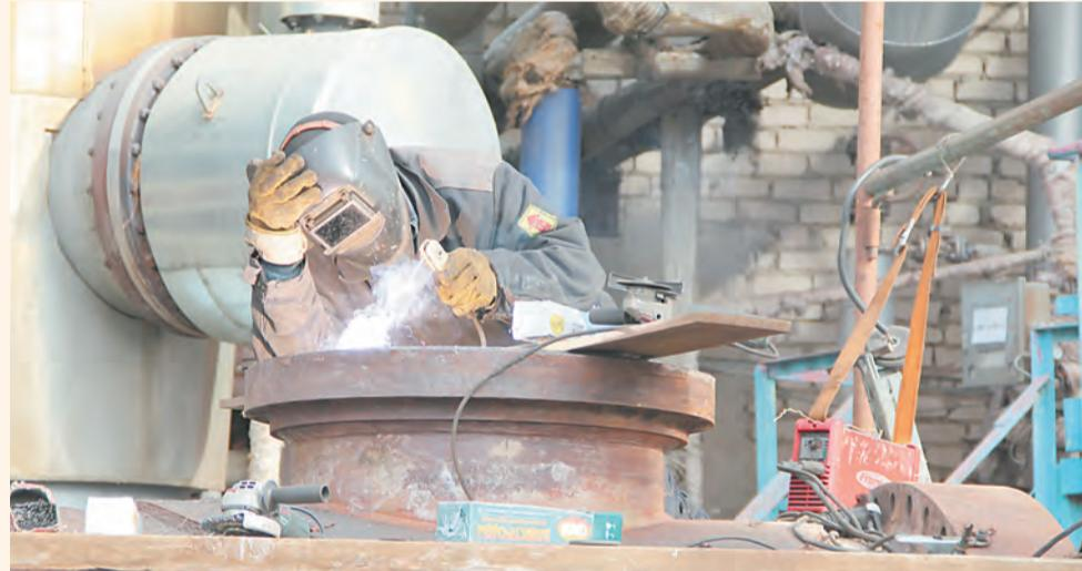
Объём запланированных работ включал в себя десятки позиций как в основных цехах, так и во вспомогательных подразделениях. В частности, в цехе по производству аммиака был отремонтирован котёл-utiлизатор, дефектный участок трубы на вспомогательном котле. Кроме того, были проведены плановые работы на отпарной колонне конденсата, насосе трубного конденсата, воздушном холодильнике, а также чистка аппаратов водяного охлаждения.
