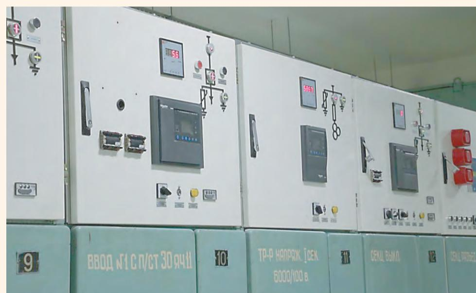
На подстанции также произведена модернизация релейных отсеков. Если раньше применялись электромагнитные реле, то сейчас используются микропроцессорные блоки защиты. Реконструкции подверглась и система оперативного постоянного тока, которая отвечает за питание резервных маслонасосов, цепей управления и защиты ячеек 6 кВ, аварийного освещения цеха. Появился новый распределительный щит и выпрямители. Также в рамках ремонта заменили кабели на разгонных электродвигателях 6 кВ отделения 5Б.
