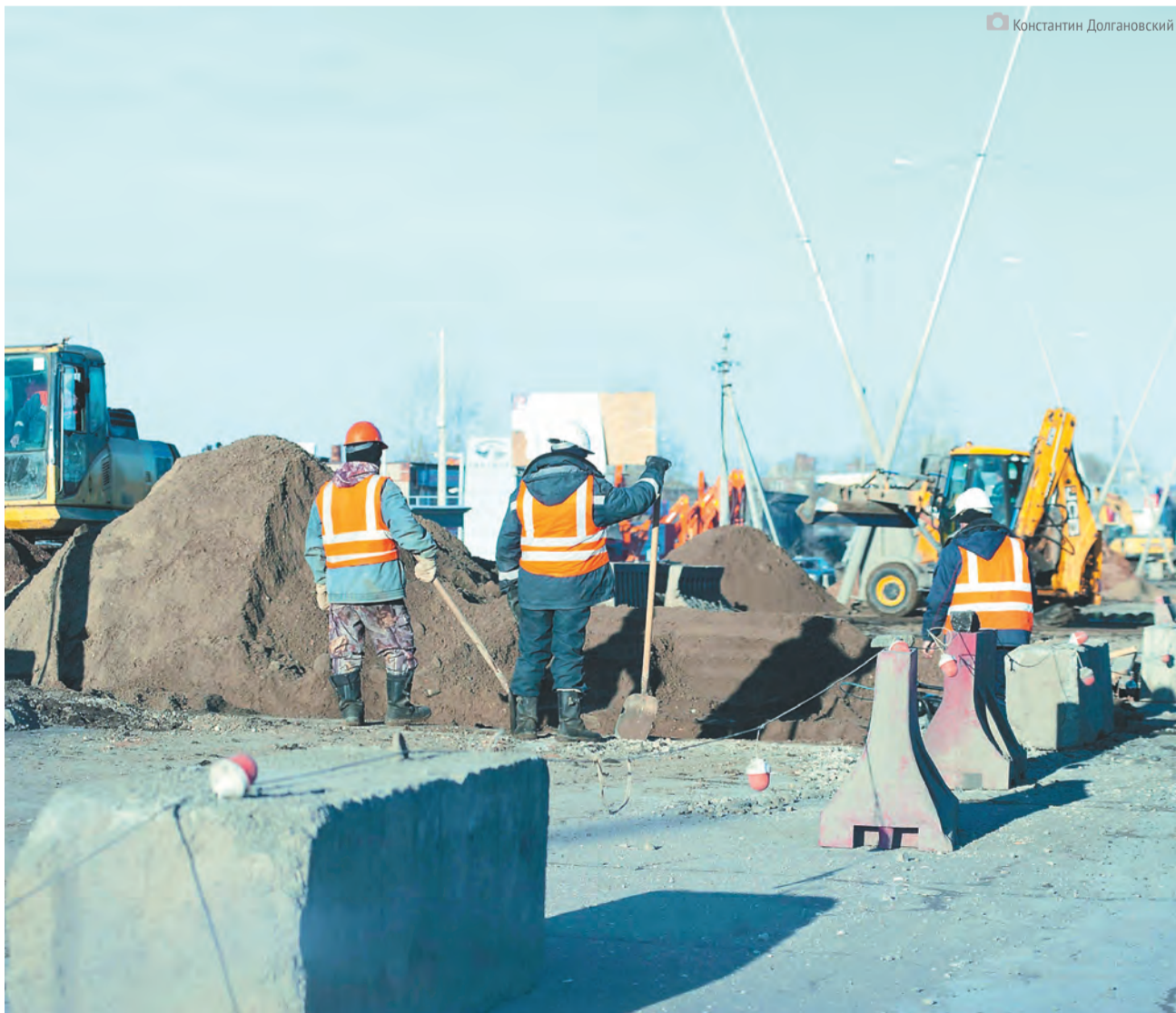
На шоссе Космонавтов сейчас укладывают новое дорожное покрытие, строят пешеходные надземные переходы и ведут работы по устройству развязки на аэропорт
