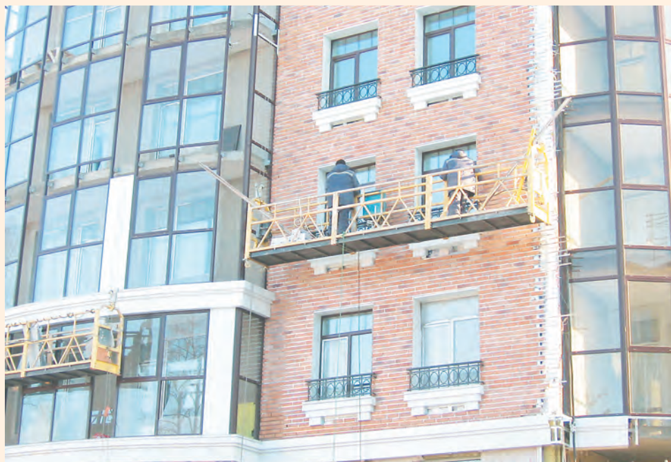
Монтаж клинкерного фасада
