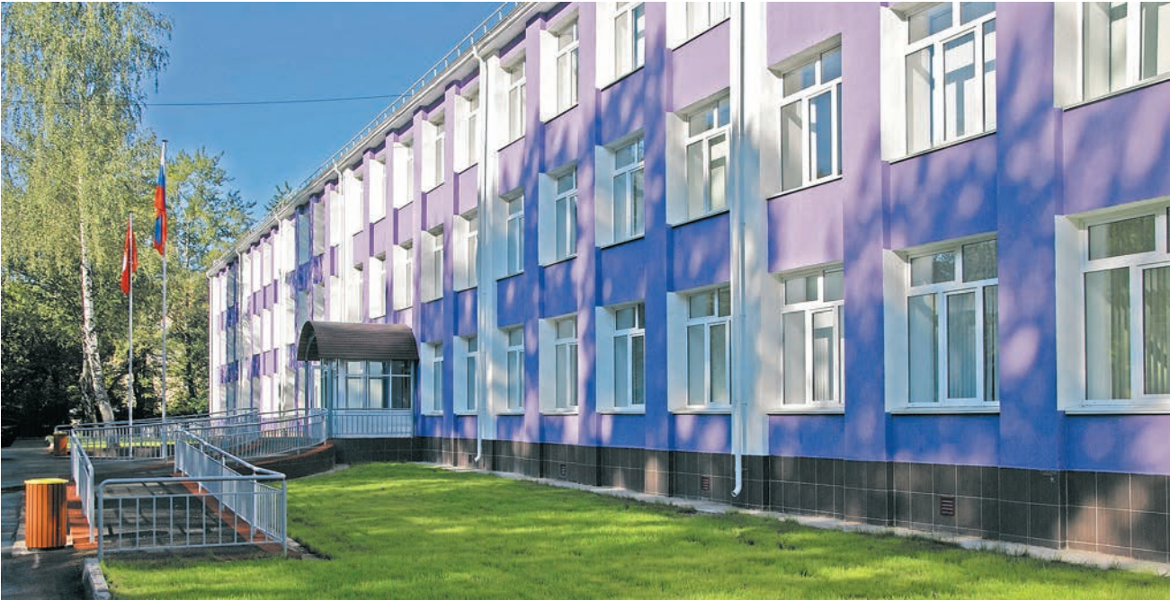
После капитального ремонта школа №114 сильно изменилась и внутри, и снаружи
