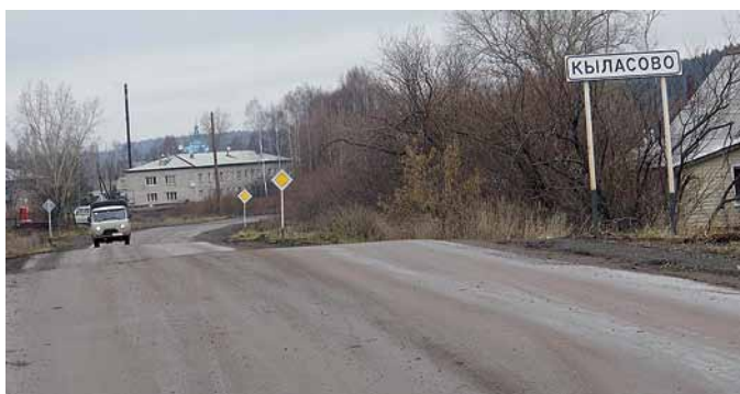
Отремонтированный участок дороги в Кыласово
