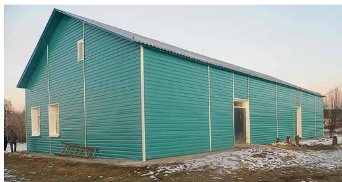
Отремонтированный Дворец культуры в Казаево
