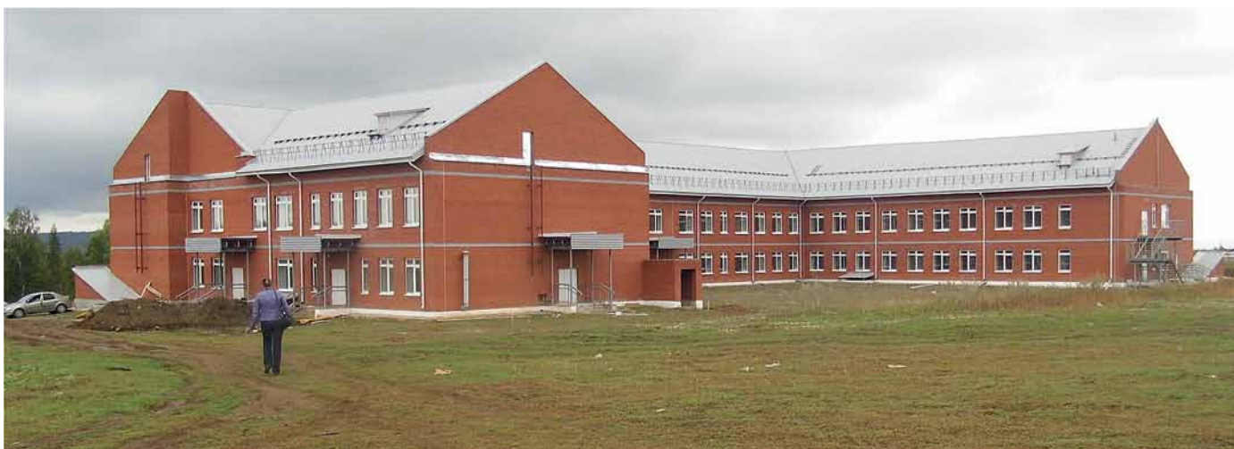
Строящаяся школа в Бажуках
