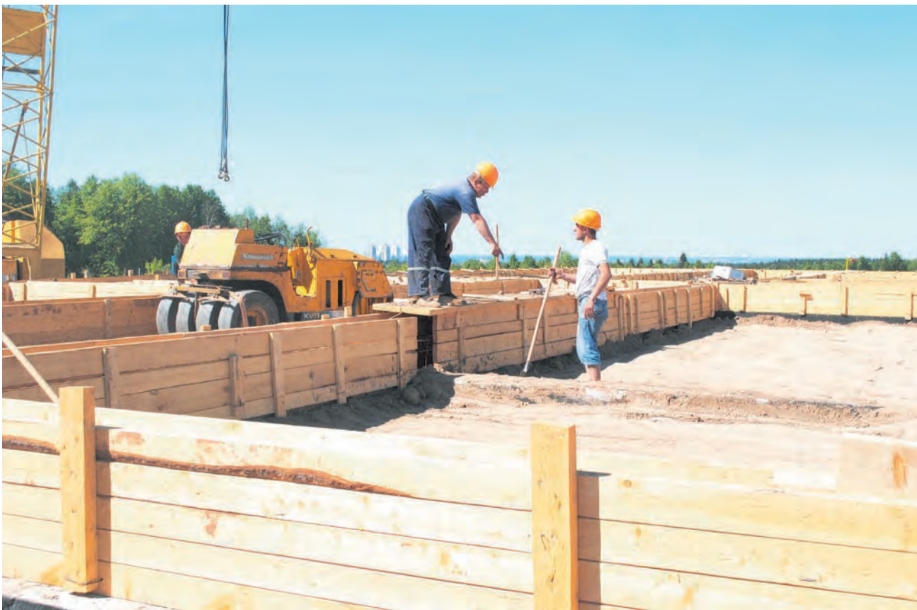
На месте будущего крематория сейчас ведутся работы по устройству фундамента здания
