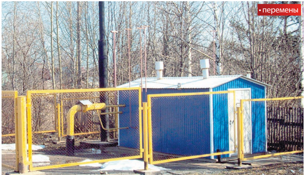
Процесс строительства газопровода для домов Средней Курьи и Камской долины близится к завершению
