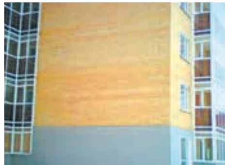
Пример кирпичного домостроения: Грачёва, 19. Тепловизор выявил зоны повышенных температур между этажами, в углах здания, в местах примыкания оконных проёмов
