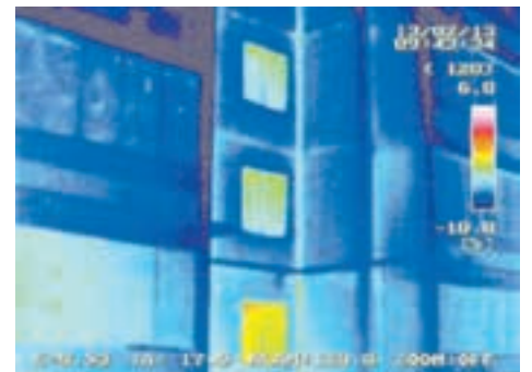
Дом по ул. Черняховского, 57, который построен из панелей серии Э-600. Области незначительного повышения температуры — во внутренних углах здания и в местах примыкания стеклопакетов
